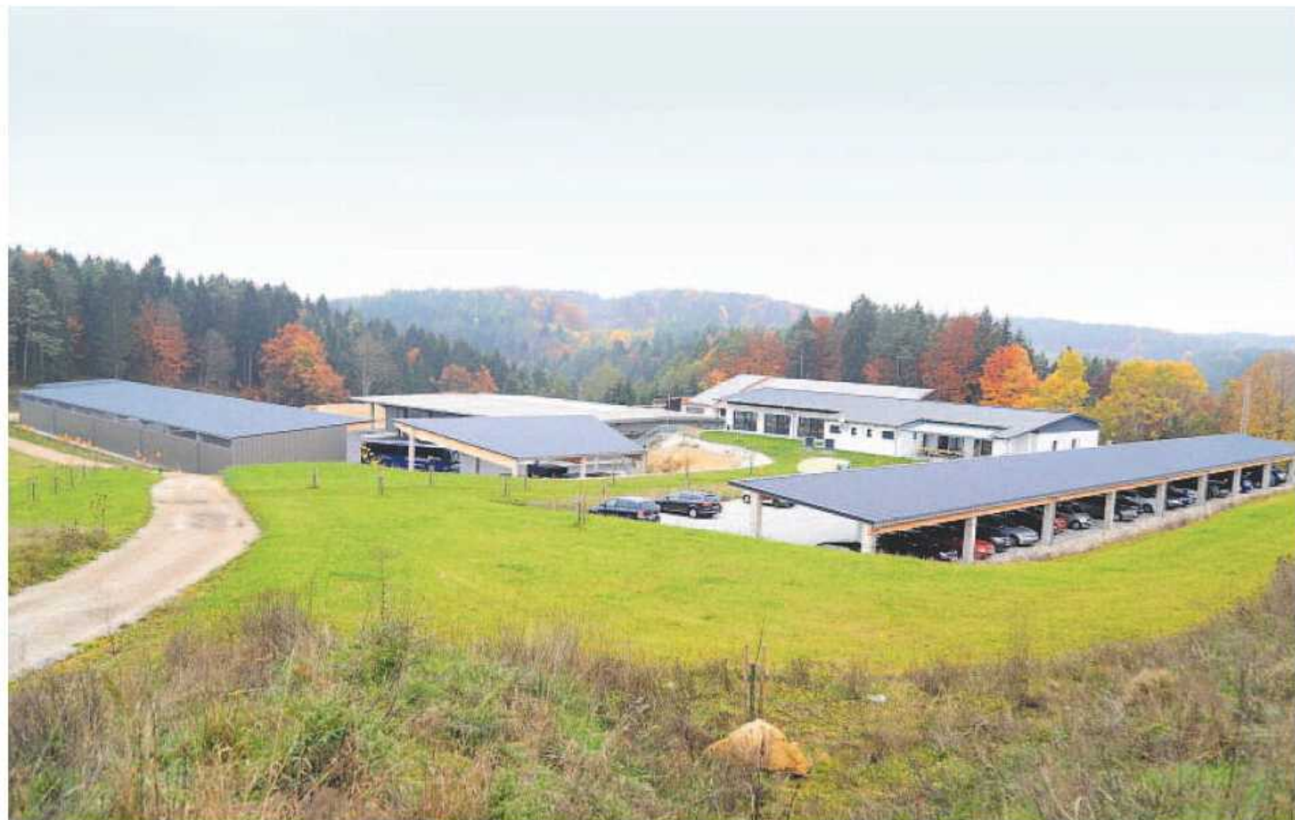
In die Landschaft eingebettet ist das neue, rund 40 000 Quadratmeter große Gelände der Firma Schmetterling. Hier stehen das moderne Verwaltungsgebäude, eine Warmhalle mit Waschhalle, eine Tankstelle und Carports. Fotos: Franz Galster
